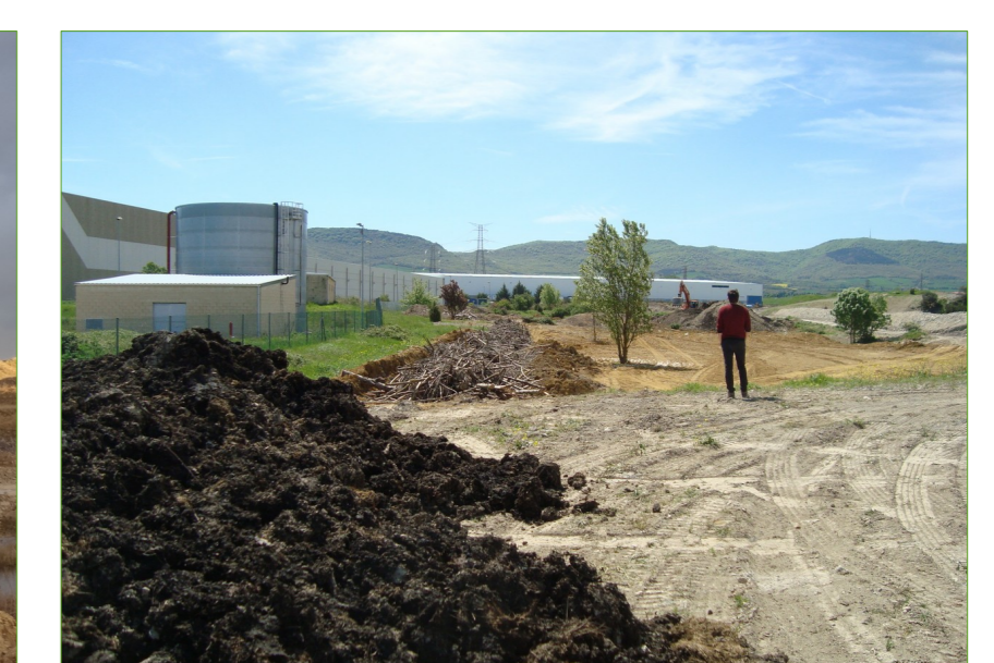
Zanja abierta y relleno con materia orgánica
